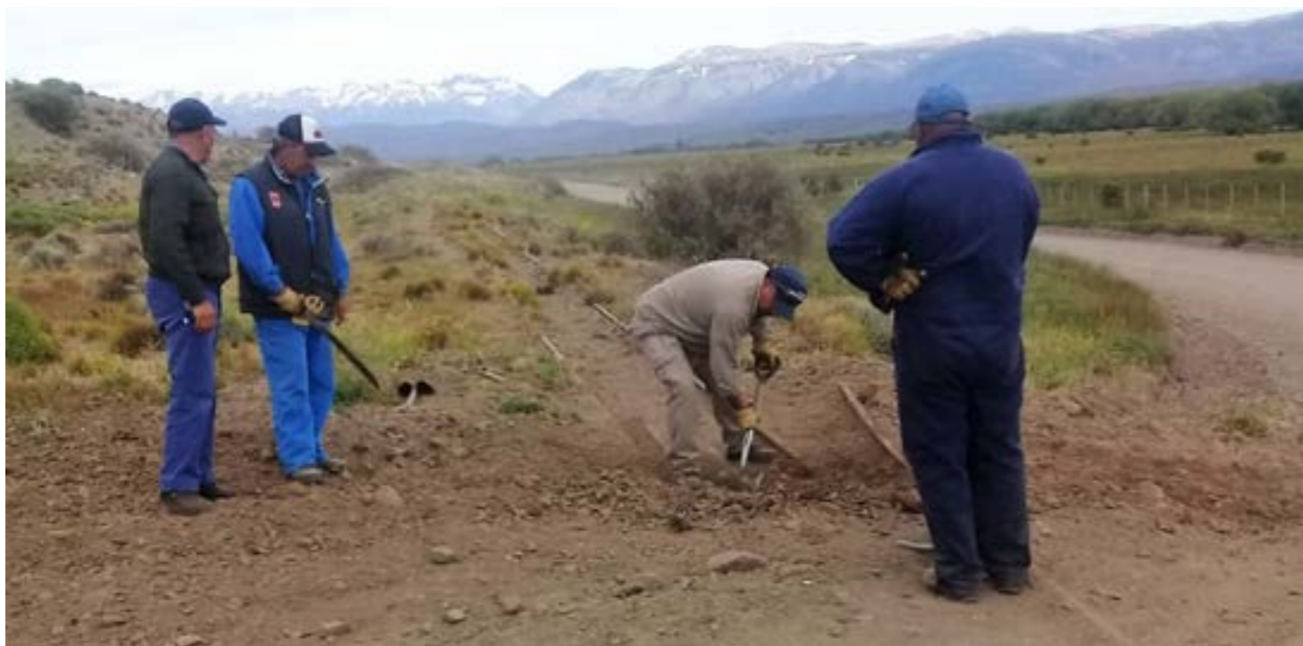
La gente de El Maitén trabaja en el destape de la vía a Ñorquincó a pico y pala.
